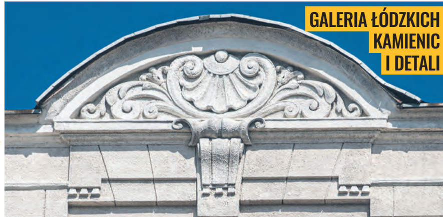
Detal architektoniczny kamienicy Abrama Perlmuttera i Abrama Ritterbanda przy ul. Piotrkowskiej 40 zbudowanej w latach 1913–1915
