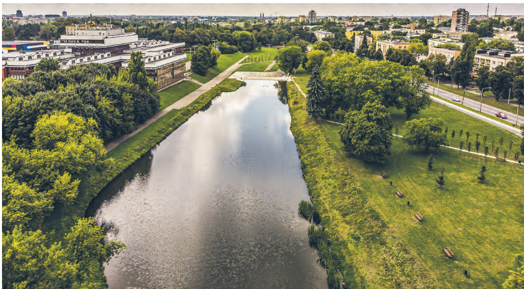
STAW NA ŁÓDCE. Koło Akademii Sztuk Pięknych powstał malowniczy staw na rzece. Jego zadaniem jest zbieranie deszczówki podczas obfitych opadów. Wcześniej rzeka zalewała ul. Sporną.
