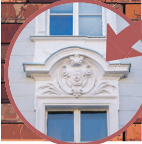
Tak wypiękniata kamienica przy ul. Żwirki 16
