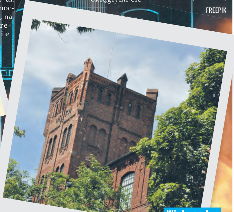
Wieża wodna zakładów Kindermanna
