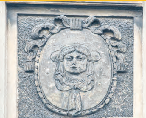
Detal architektoniczny kamienicy przy ul. Nawrot 15
