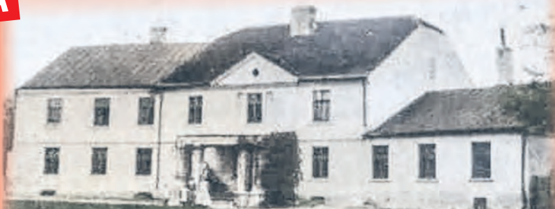
Dawny dwór Reymonta w Charłupii Wielkiej w ciągu wielu lat popadł w kompletną ruinę
