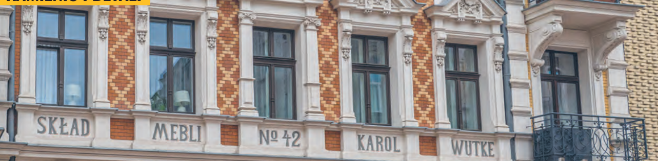
Detale architektoniczne zrewitalizowanej kamienicy Karola Wutkego przy ul. Jaracza 42
