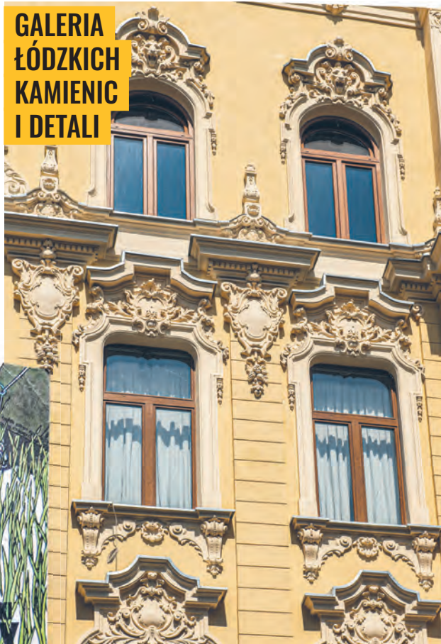
Detale architektoniczne zabytkowej kamienicy z 1898 r. przy ul. Rewolucji 1905 r. 20 zbudowanej wg projektu architektów Gustawa Landaua-Gutentegera i Franciszka Chelmińskiego
