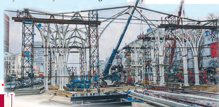
Budowa przystanku (2015 r.)
