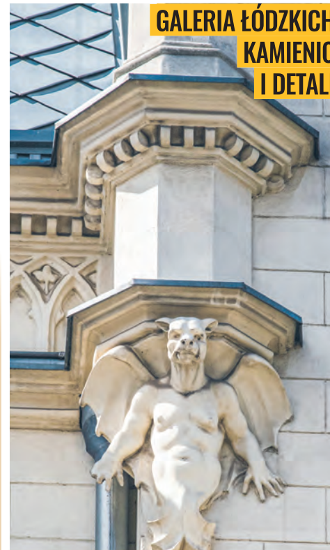
Detal architektoniczny zabytkowej kamienicy Szai Goldbluma przy ul. Piotrkowskiej 99 z 1898 r.
