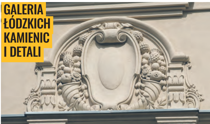
Detal architektoniczny kamienicy przy ul. Nawrot 4, wybudowanej w 1913 r. przez Karola i Amelię Mogków oraz Rudolfa i Laure-Idę Romerów (Röhmer)
