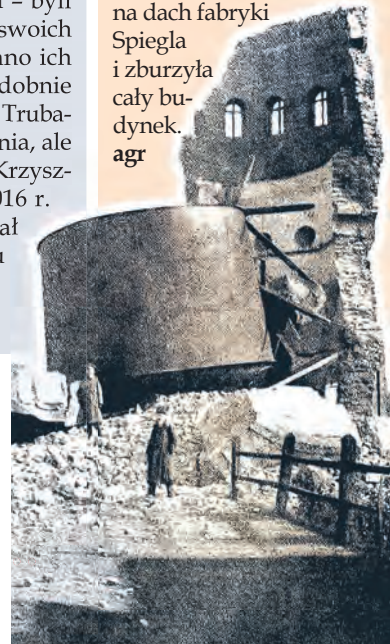
Zbombardowana w 1914 r. wieża ciśnieni na Dworcu Kaliskim
