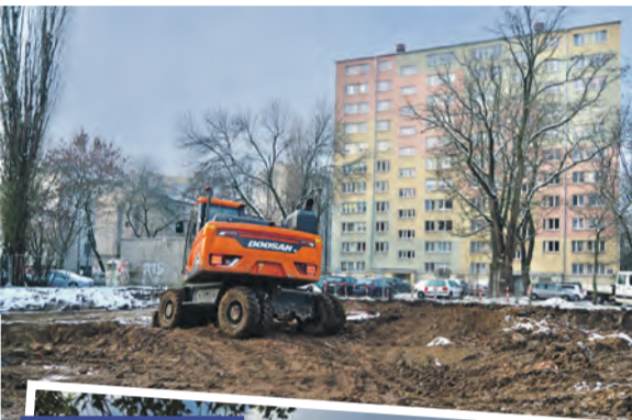
Tak ma wyglądać gotowy blok
