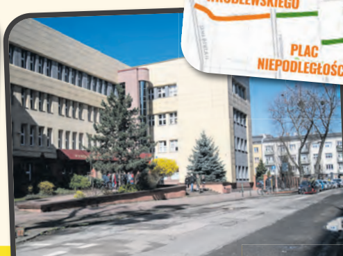
Ul. POW przed remontem
